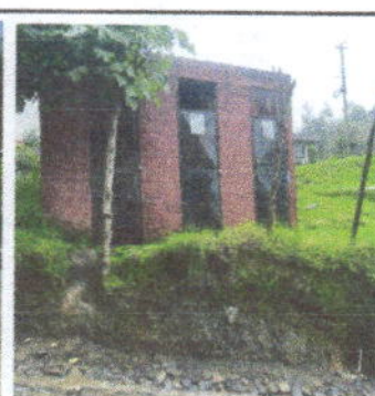
Foto 6: SERVICIOS SANITARIOS, la puerta de los sanitarios están en la orilla del borde, están en mal estado por lo que es indispensable cambiarlos de posición y realizar una remodelación completa
