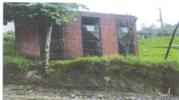
Foto 2: Sustitución de puerta en servicios sanitarios por deterioro debido a los cambios climáticos y no cuentan con techo que proteja las puertas
